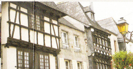
Maison à colombage - Rue Brizeux
